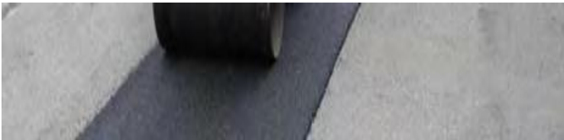
Abbildung 2: Einbaubeispiel zur Reaktivasphalt-Technologie [2]
